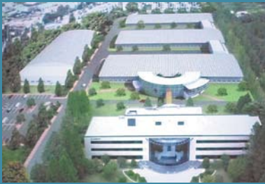
↑ Производственная площадка предприятия TaeguTec в Южной Корее
